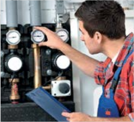
Εγκαταστάτες συστημάτων θέρμανσης/ υδραυλικών συστημάτων
