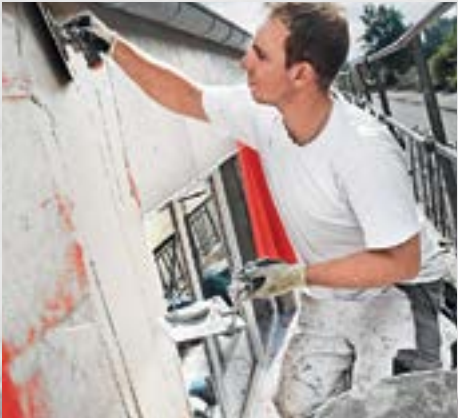
Σοβατίσματα / Εσωτερικές επισκευές / Ελαιοχρωματισμοί
